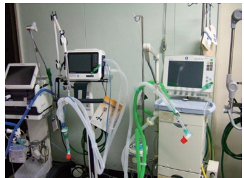
▲使用後や定期的な点検整備を行い、データベースを用いて、一元的に管理しています
